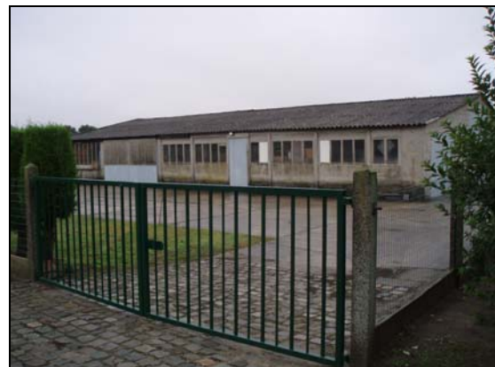
Foto 2 – bestaande bebouwing op het terrein
