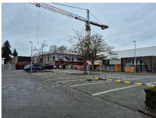
Figuur 2.3-1 Bestaande schoolgebouw (linksboven), nieuwbouw in opbouw (linksonder) en sporthal (rechtsboven)
