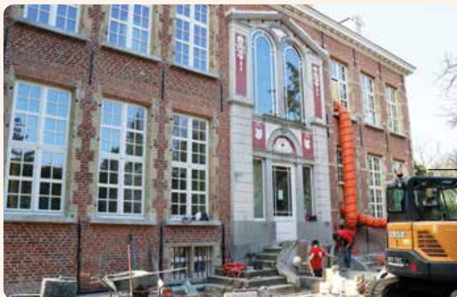
Aan de kant van de Frankrijkstraat werd de originele kasteeltrap terug geïnstalleerd na een grondige restauratie.
