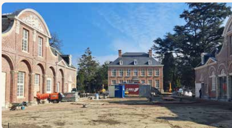
Het binnenplein transformeert stilaan terug van drukke werfzone naar open ruimte.
