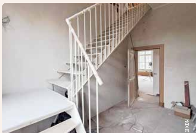
Zoldertrap in het kasteelgebouw
