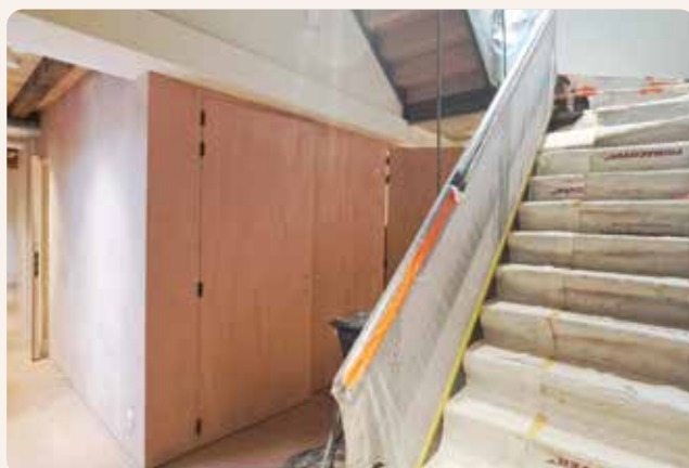
Toiletten in het Portiershuis
