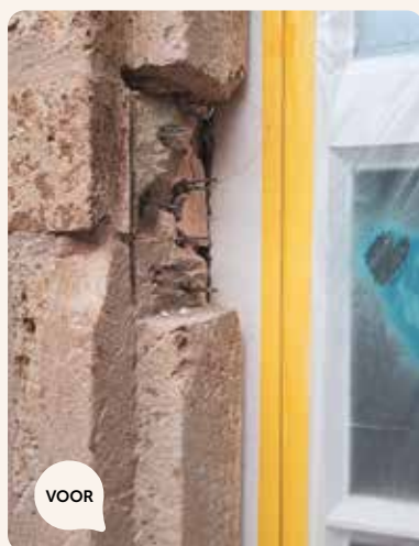
De gevels kregen een grondige opknapbeurt: uitgehakte voegen werden zorgvuldig opnieuw opgevuld en stenen hersteld met minerale mortel.
