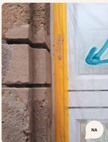
De gevels kregen een grondige opknapbeurt: uitgehakte voegen werden zorgvuldig opnieuw opgevuld en stenen hersteld met minerale mortel.
